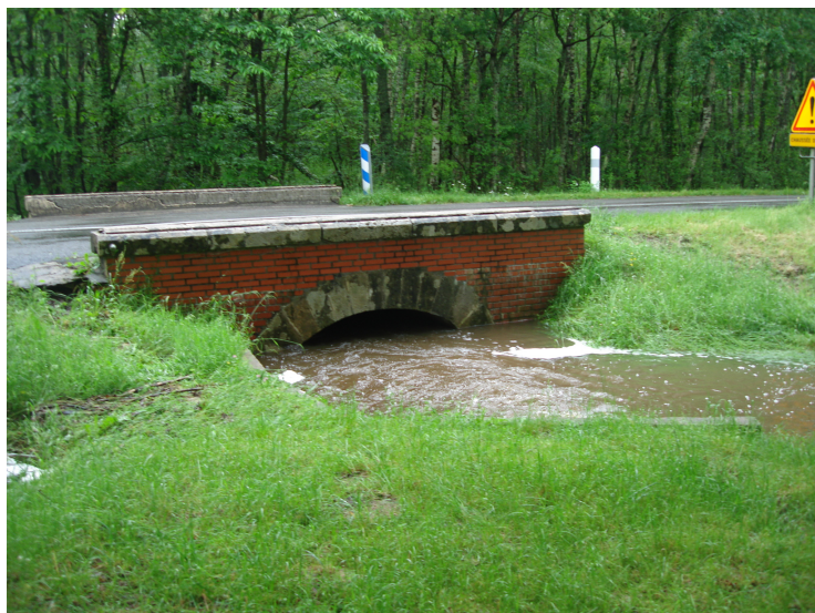
Photo 11 : vue en aval du déversoir l'étang, au niveau de la RD 17, le 30 mai 2016
