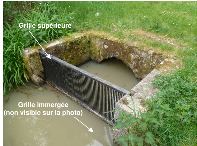
Photo 2 : Aval de la prise d'eau
